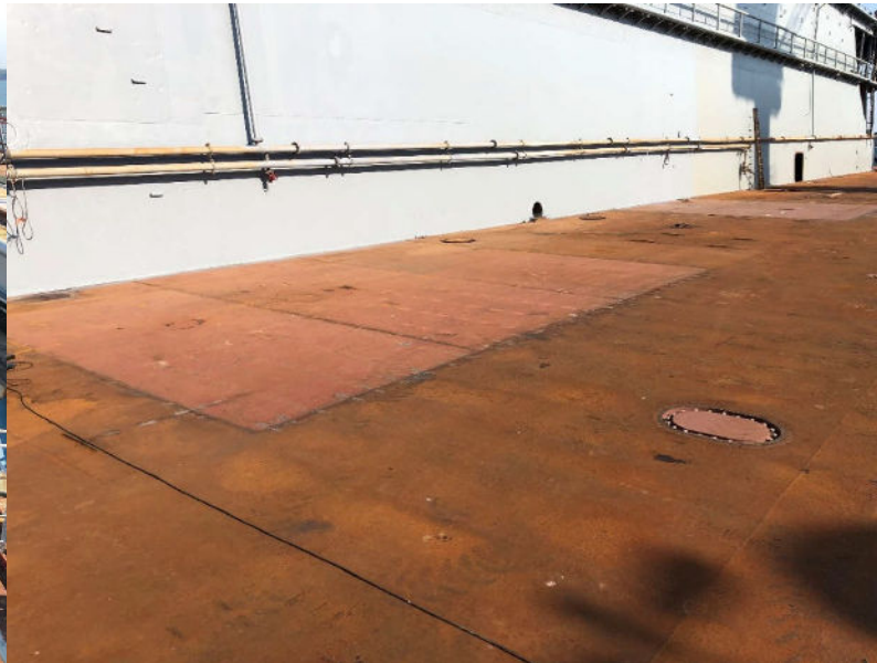
Fertig eingesetzte Platte Tankdecke
